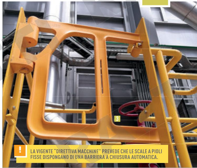
**!** LA VIGENTE "DIRETTIVA MACCHINE" PREVEDE CHE LE SCALE A PIOLI Fisse DISPONGANO DI UNA BARRIERA A CHIUSURA AUTOMATICA.
